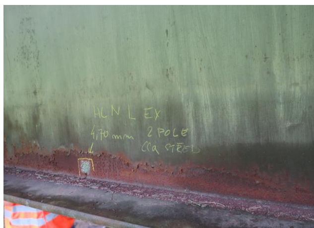
K01 - detail měřicího místa oslabené stojiny ve 2. poli z vnější strany
