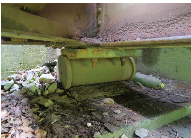
K01 - detail oslabení stojiny nad ložiskem z vnitřní strany
