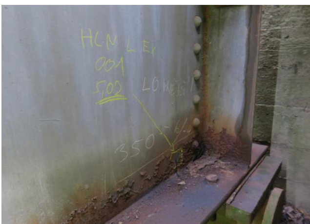
K01 - detail měřicího místa oslabené stojiny nad ložiskem z vnější strany
