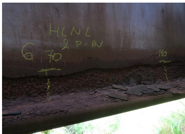
K01 - detail oslabení stojiny ve 2. poli z vnitřní strany
